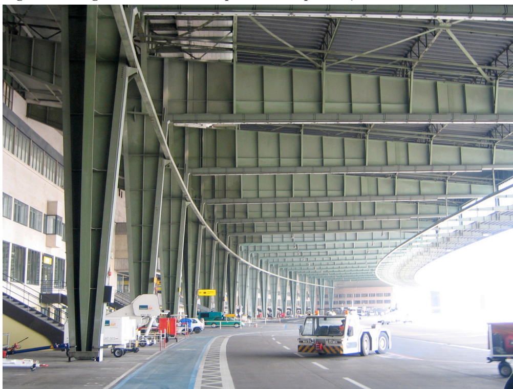
Figure 4. Hangars de l'ancien aéroport de Tempelhof (1935-1941, architecte : Ernst Sagebiel)
