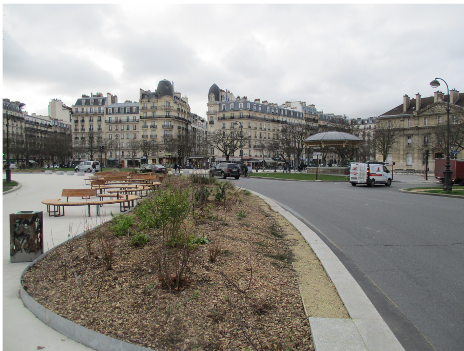
Figure 2. Le réaménagement de la place de la Nation
