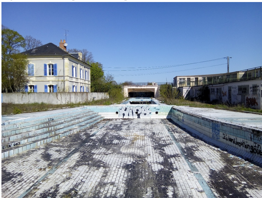
Figure 1. Ancienne piscine municipale de Nevers
